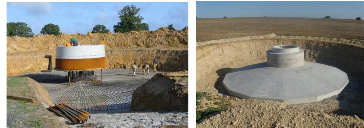
Photo 2 : Le ferrailage et le coulage d'une fondation d'éolienne
